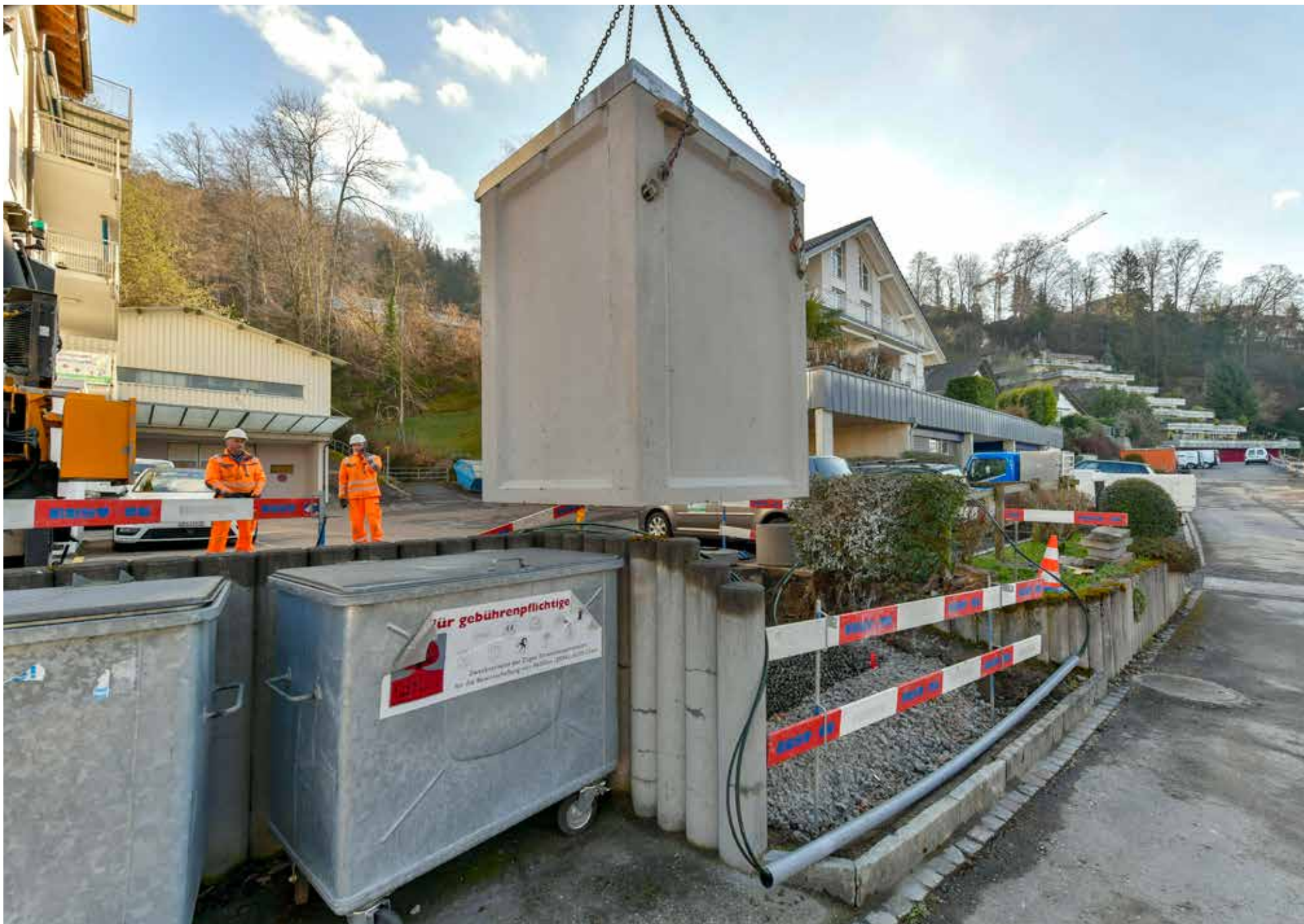
UFC-Einbau: Das beim Lieferanten gefertigte Betonelement wird in die vorbereitete Baugrube eingelassen.
