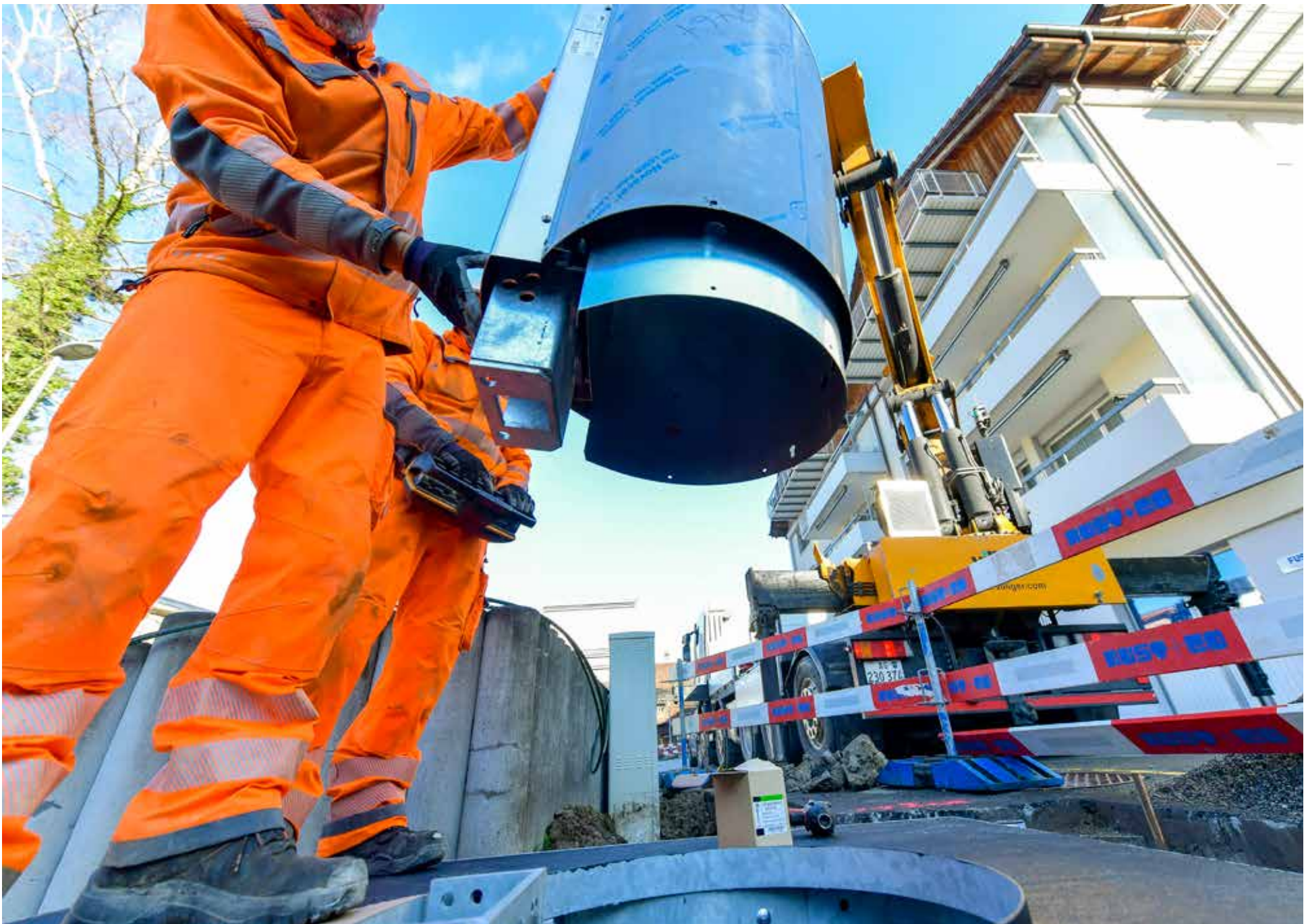
UFC-Einbau: Montage der Einwurfsäule.
