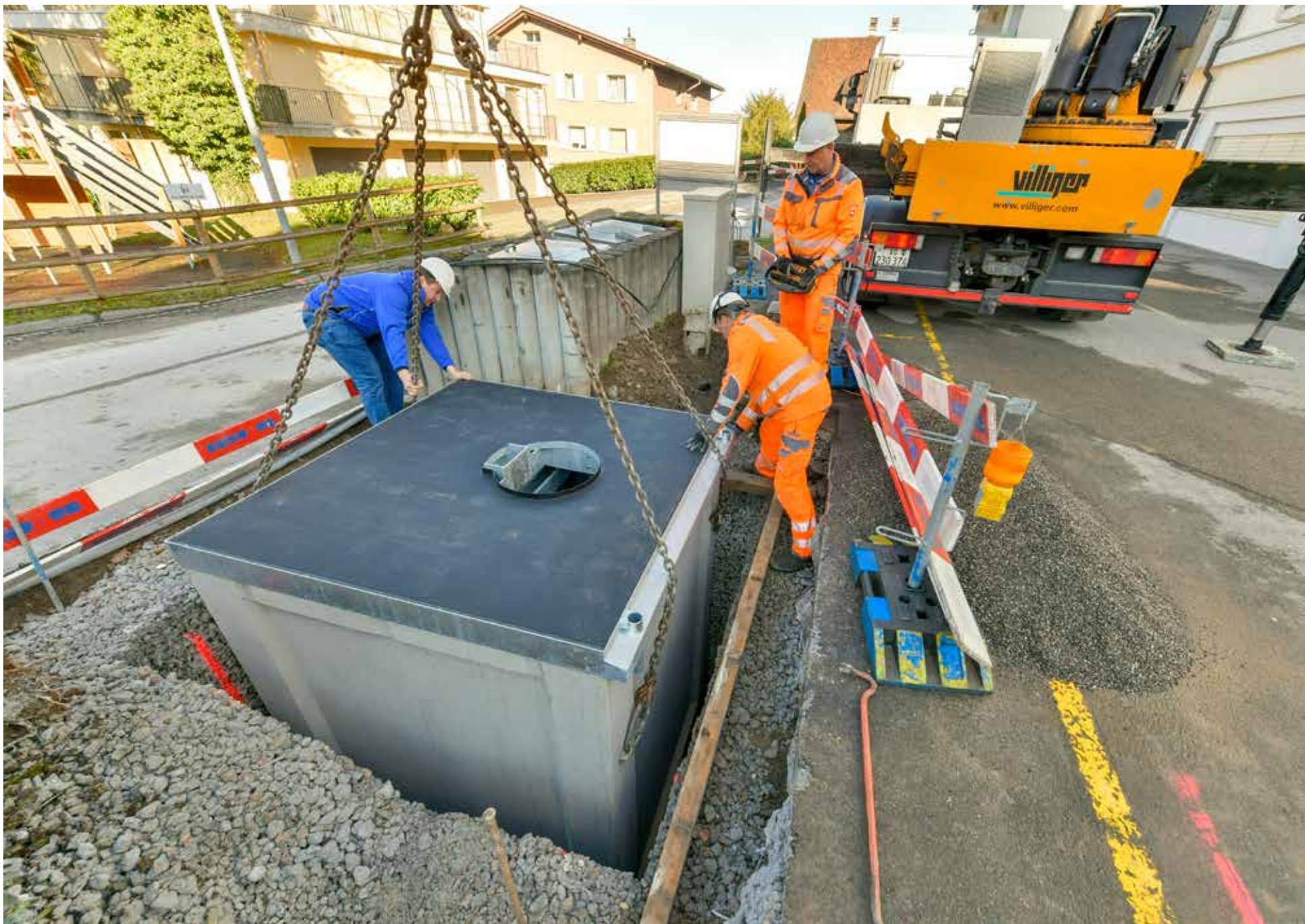
UFC-Einbau in Walchwil: Teamarbeit, die Einwurfsäule ist seitlich versetzt.
