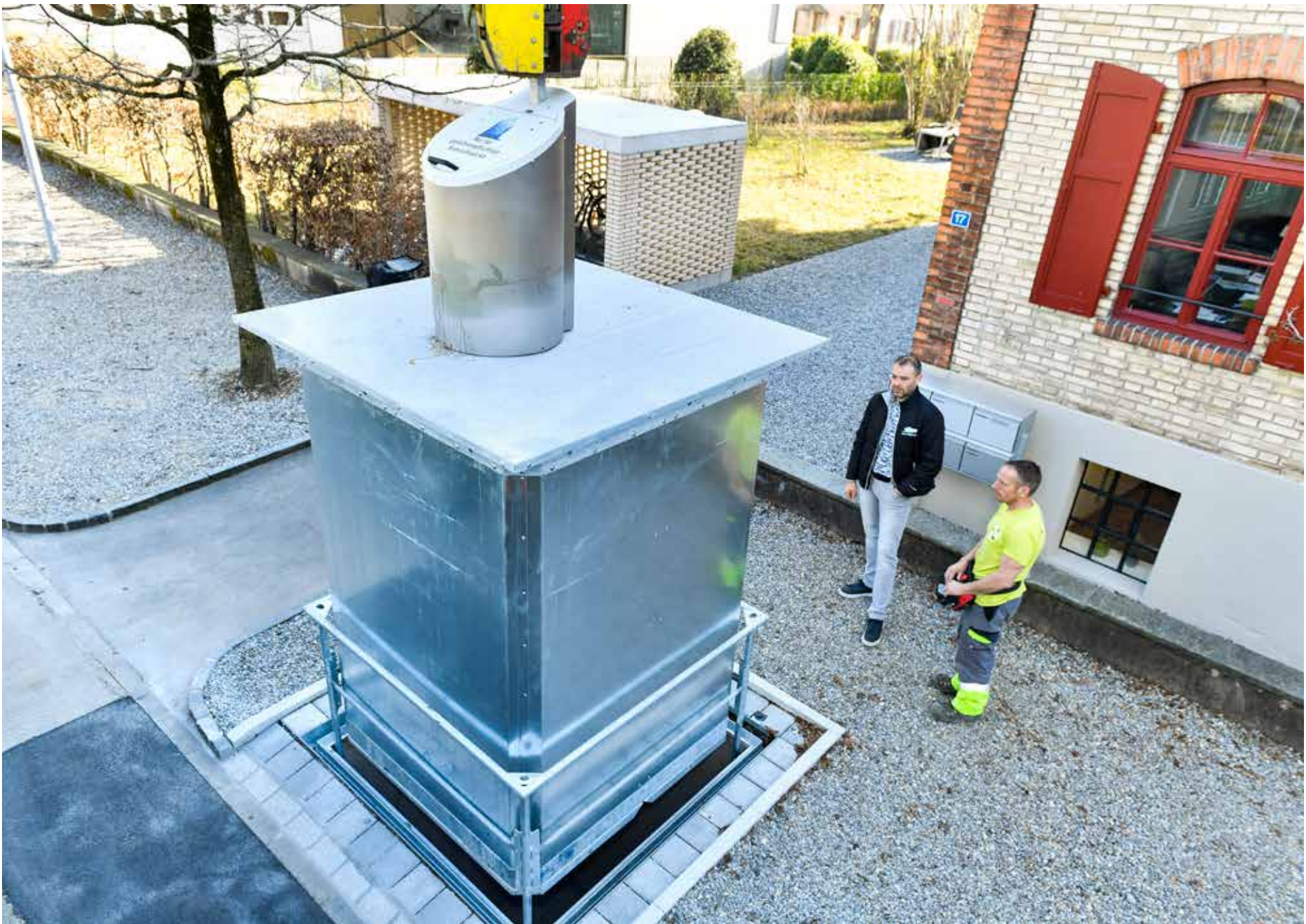
UFC an der Bundesstrasse in Zug: Der Container mit Säule ist mehr als drei Meter hoch. Für die Leerung wird er über die Oberkante des LKW gehoben.
