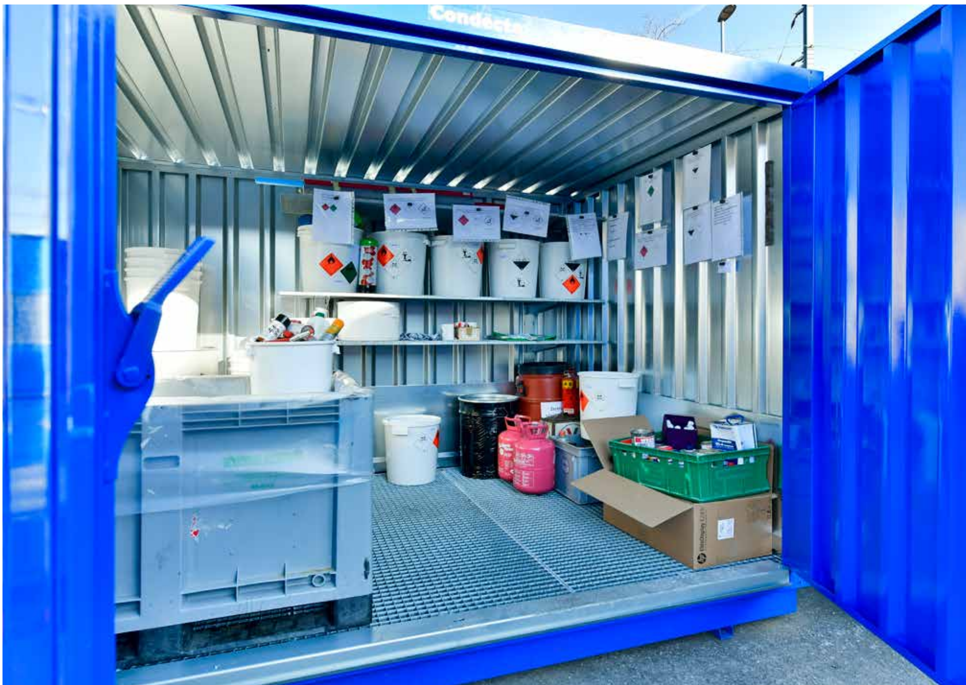
Giftcontainer beim Ökihof in Baar: Widerstandsfähige Kunststoffgebinde und doppelter Boden schützen vor Schäden, falls wider Erwarten ein Leck auftritt.
