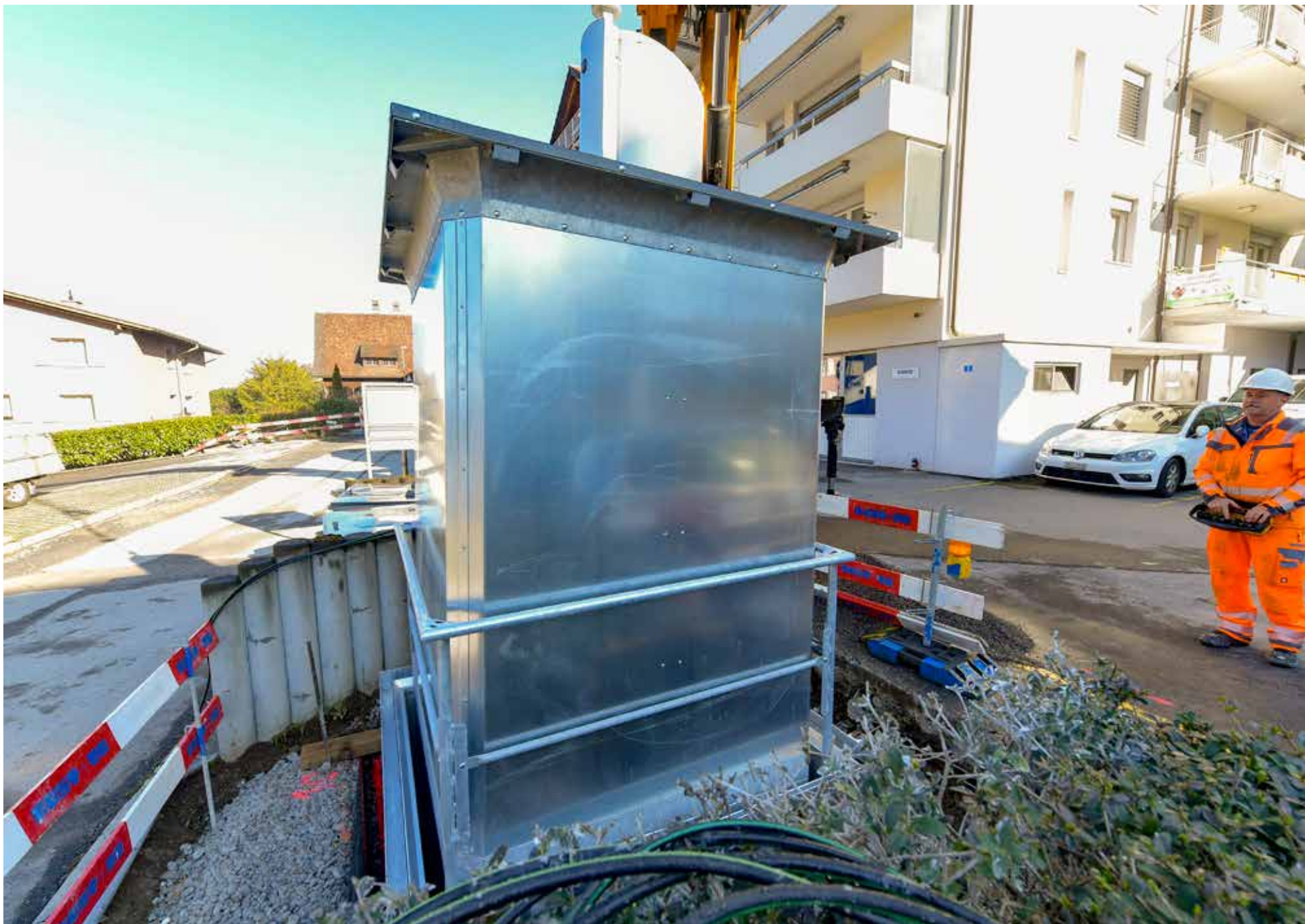
UFC-Einbau in Walchwil: Die Absturzsicherung wird mit der Entnahme des UFC sichtbar.
