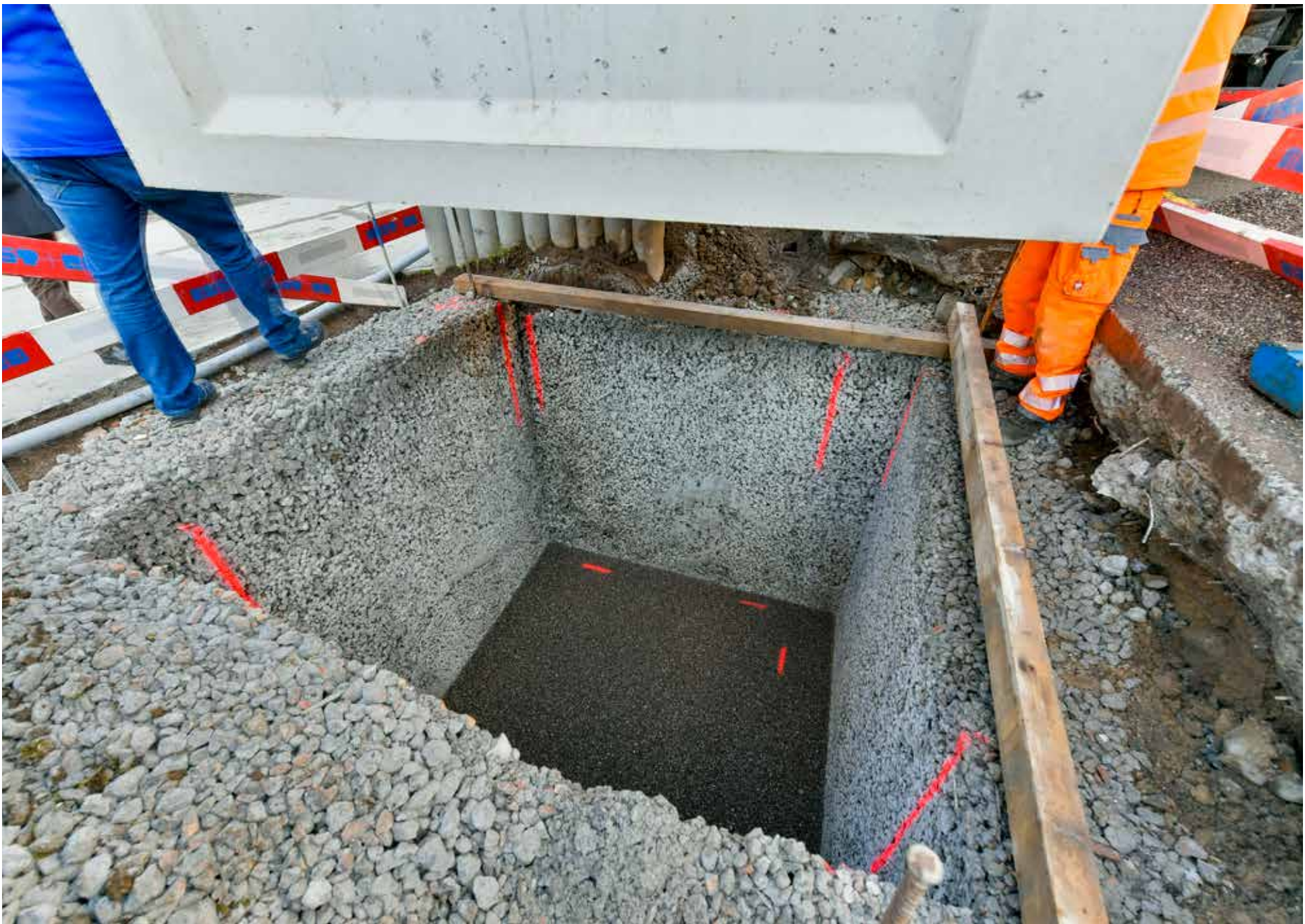
UFC-Einbau: Die Baugrube ist bereit zum Einsetzen des vorgefertigten Betonelements.
