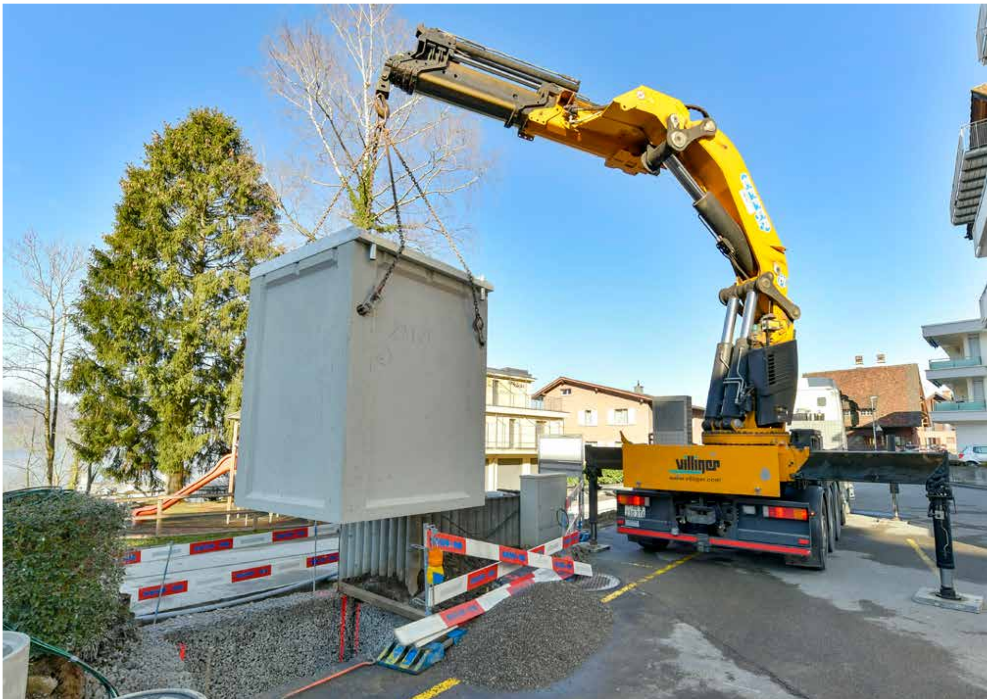
UFC-Einbau: Der LKW kann vier Betonelemente gleichzeitig ausliefern.
