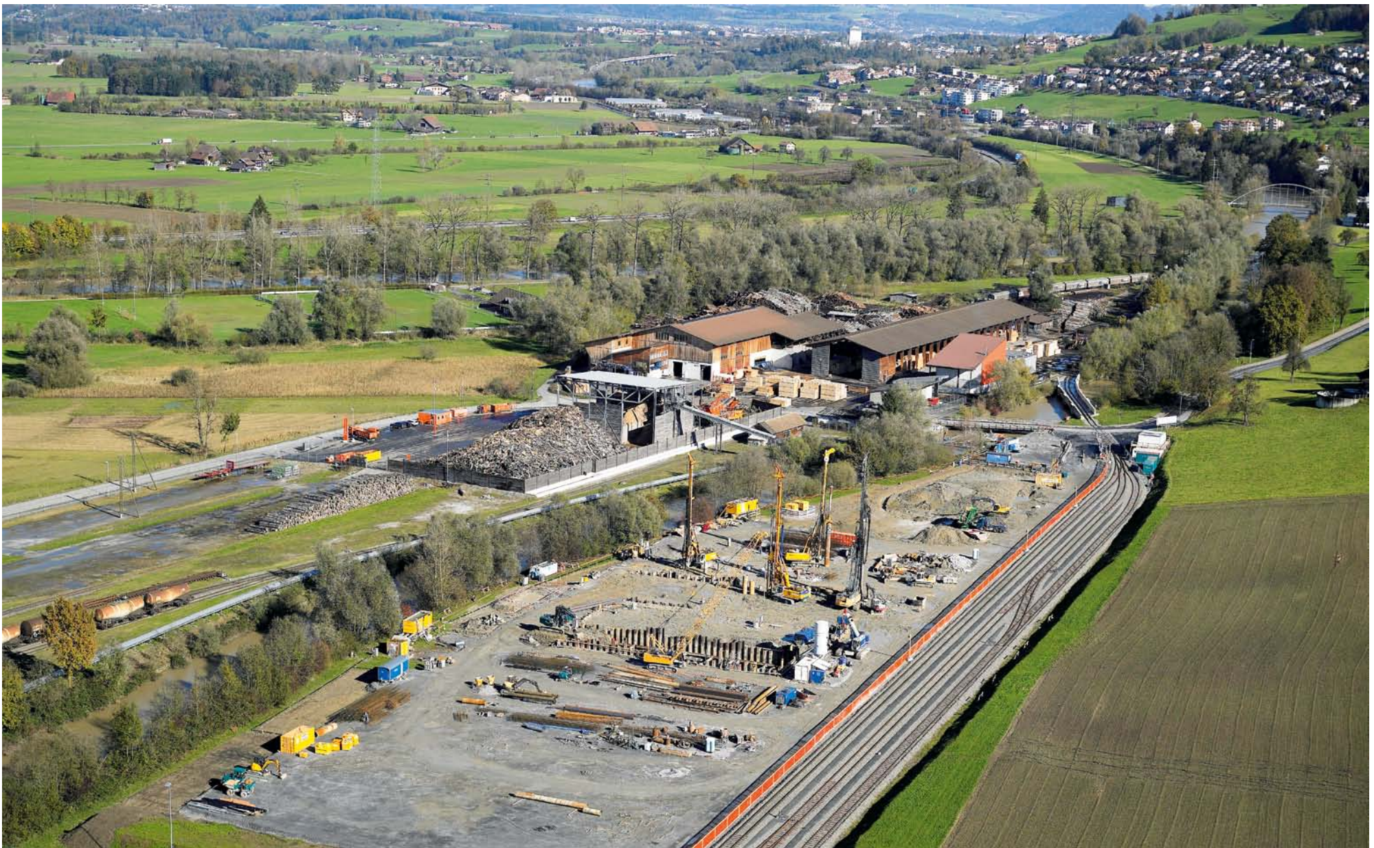
Baustelle der Renegia: Das Gelände liegt verkehrstechnisch ideal und nahe an der Zuger Kantonsgrenze. Im Hintergrund das Hochhaus mit dem Verwaltungszentrum der Roche in Rotkreuz.
