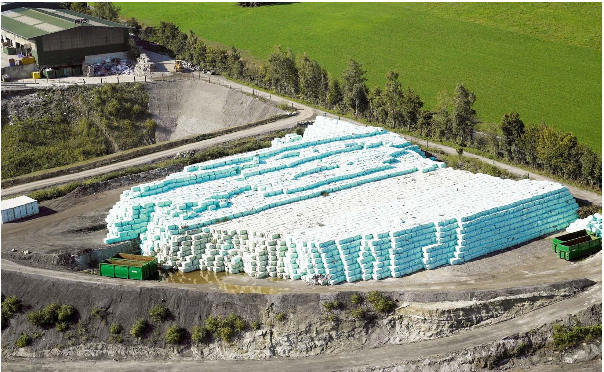
Entsorgungszentrum Tännlimoos: Zwischenlagerung von verpackten, brennbaren Abfällen, welche «just in time» bei entsprechendem Bedarf in die Kehrichtverbrennungsanlage Horgen geliefert werden.
