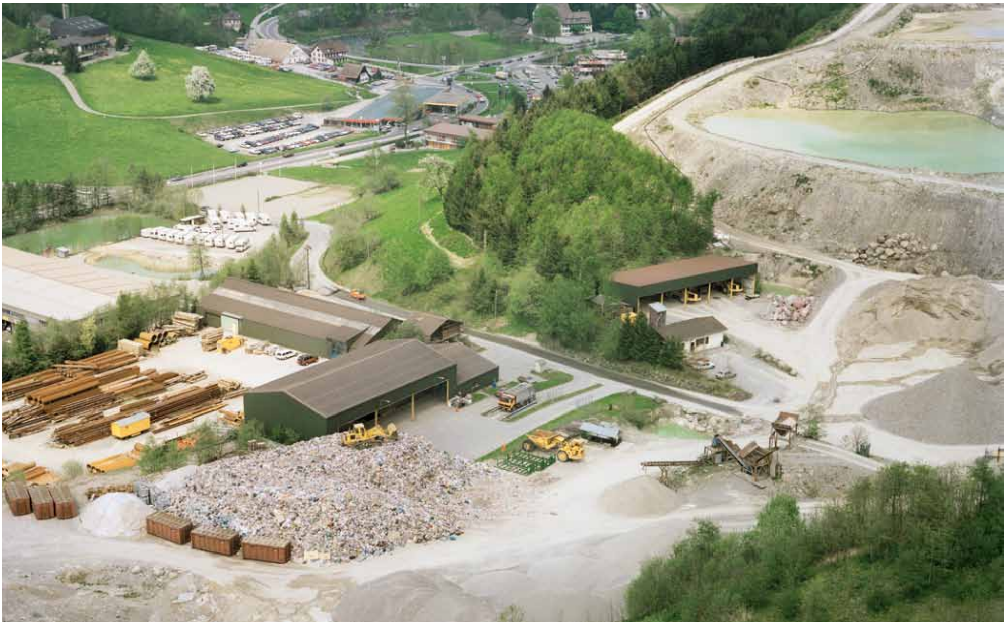
Die Kehricht-Umladestation in Sihlbrugg war in den achtziger Jahren ein Mekka der Technikentwicklung von Kehrichtsammlung und Logistik. Im Innern der Umladestation war eine Container-Verschiebeanlage für acht ACTS-Container untergebracht. Im Vordergrund der Aufnahme oben vom 8. Mai 1992 ein Zwischenlager des Kehrichts. Die drei Container ganz vorne entsprechen der ACTS-Norm mit 5.95 Meter Länge.
