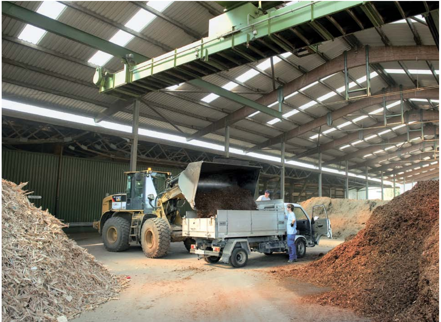
Der Kompost wird über eine Siebanlage ausgetragen und in Grob- und Feinstruktur getrennt.
