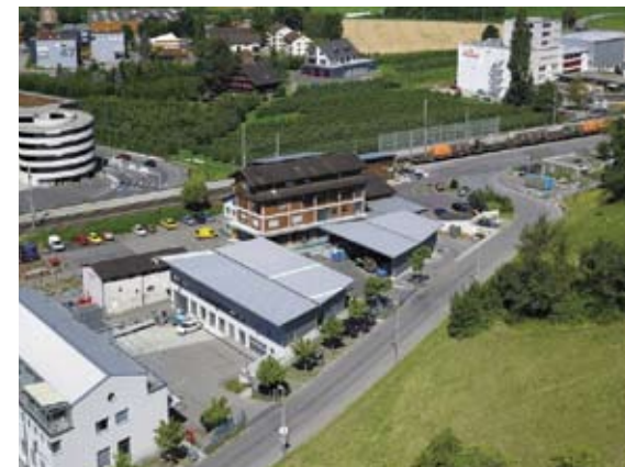
Ökihof Steinhausen: Eines der Aufnahmezentren in Zug.
