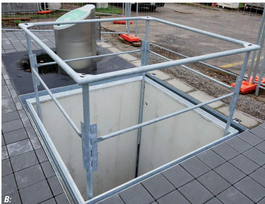
B: Mit Sicherheitsgitter geschützter Untergrund der UFC-Sammelstelle
