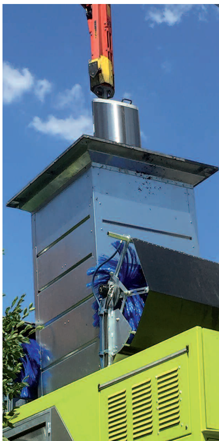
Reinigung des Containers mit Walzenbürsten
