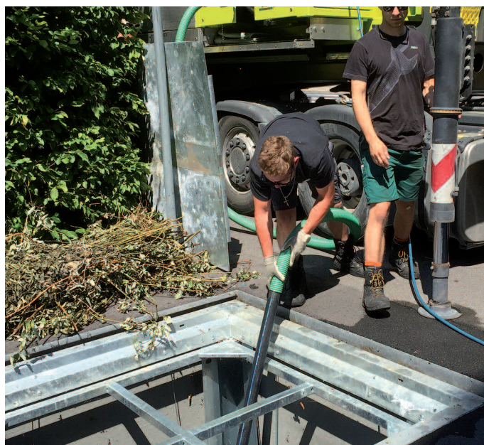
Reinigung des Betonelementes mit Wasserhochdruckreiniger
