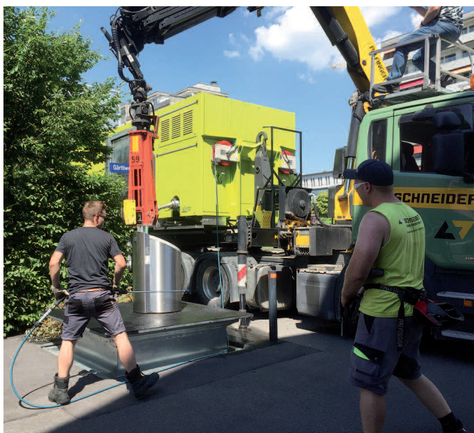
Reinigung der Gehwegplattform und Einwurfsäule mit Wasserhochdruckreiniger
