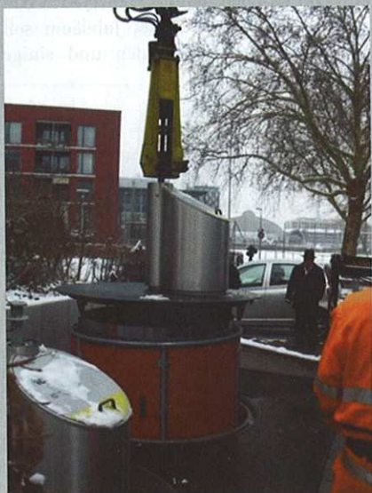
Die rote Absturzsicherung wird mit Deckel und Kehricht hochgezogen (Sammlung in Zürich)
