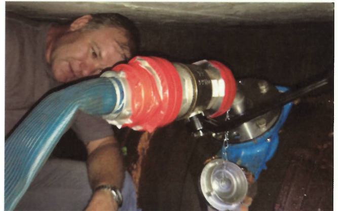
Abb. 4: Druckluftanschluss beim Zwischeneinspeisepunkt
