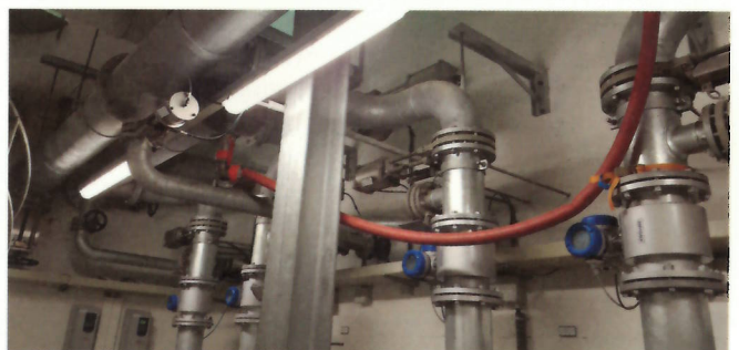
Abb. 5: Drucklufteinspeisung im Pumpwerk Küssnacht
