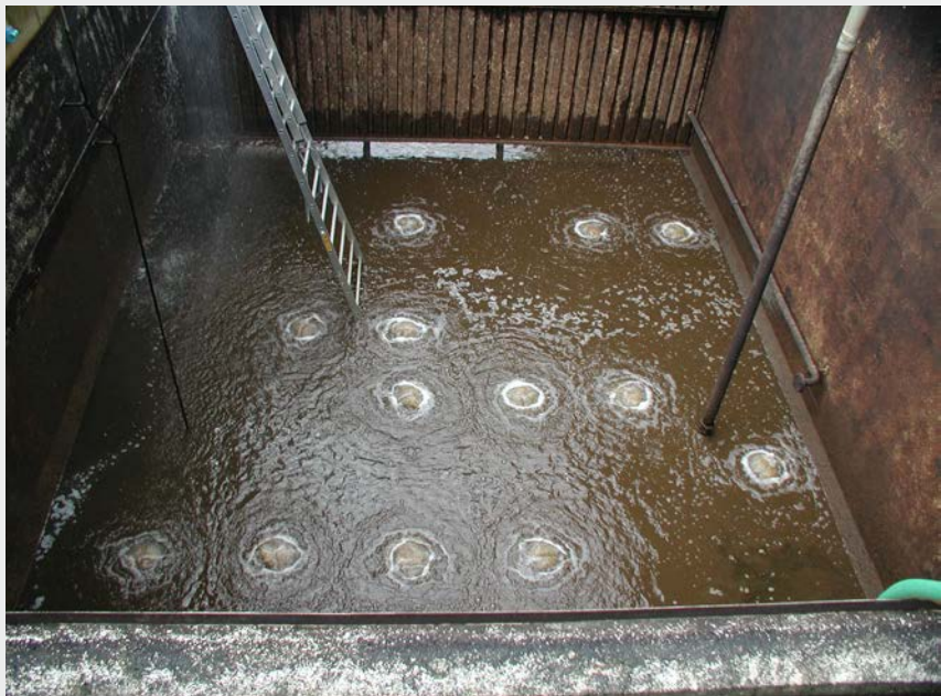
Fig. 5 Zustandsunterschiede von Belüftermembranen nach einer gewissen Zeit. Die Membranen wären gleichmässig im Becken verteilt, jedoch sind einzelne Membranteller verstopft und springen somit nur noch bei sehr hohem Luftdurchfluss an
