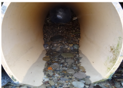
Verstopfte Einleitstelle am Tag der Aufnahmen. Blick von Rohrröffnung aufwärts.
