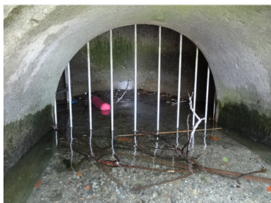
Einleitungsrohr in der Ufermauer.
