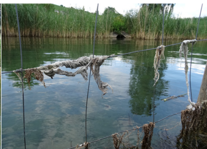
Feststoffe aus der Siedlungsentwässerung im Schilfschutzgitter vor der Einleitung.
