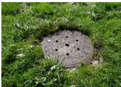
Schachtdeckel in der Wiese direkt vor der Einleitung. Wird bei Entlastung hochgedrückt. Dabei werden Feststoffe in der Wiese abgelagert.
