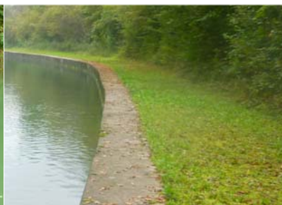
Beidseitige vollständige Böschungsfussverbauung im Oberwasserkanal.
