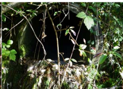
Einleitungsrohr, im Rohr viele Siedlungsentwässerungsabfälle, heterotropher Bewuchs.
