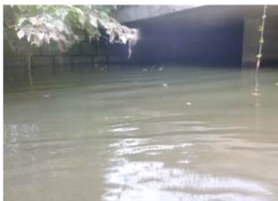
Stelle unterhalb der Einleitstelle, starke Trübung des Wassers, vollständige Verbauung des Böschungsfusses, Rückstau vom Zugersee.
