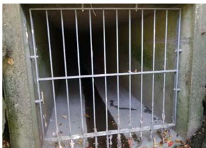
Einleitstelle BA01AE mit Grobrechen versehen, mündet in die Neue Lorze.
