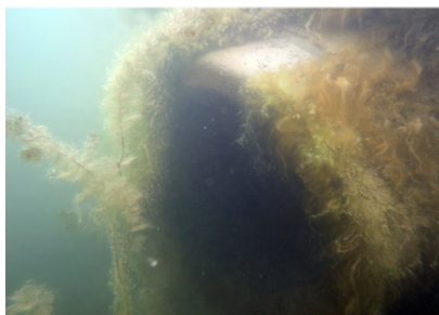
Einleitung mündet auf 1.0 m Wassertiefe in den See.
