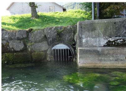
Einleitungsrohr in der Ufermauer.
