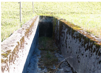
Entlastetes Wasser wird über einen Kanal in den Edlibach geleitet.
