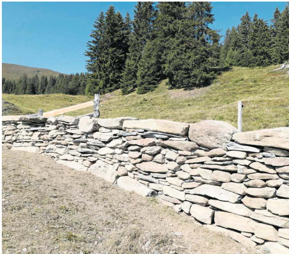
Die 18 Laufmeter lange Trockenmauer.
