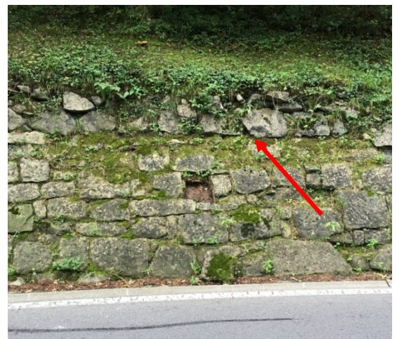
Abb. 2: Ansicht an Stützmauer. Sichtbar die nachträgliche Mauererhöhung (horizontale Linie). (BEZ 09.08.2017)
