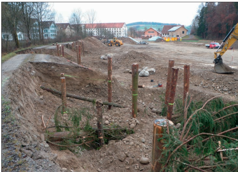
Abb. 4: Abfolge von Baumbuhnen als Strömungsablenker in den Kurvenaussenseiten. Der neue Flusslauf folgt dem abhumusierten Bereich in Richtung der Baubaracken (Foto: Tiefbauamt Kanton Zug).
