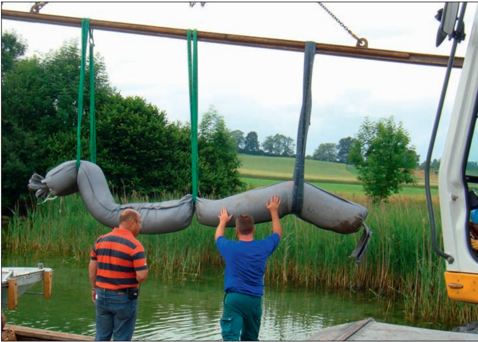
Abb. 4: Kliffkantenschutz Buonas mit Geotextilwalzen; 2009.
