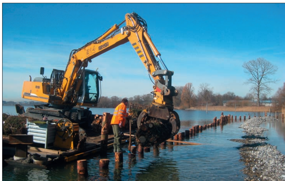
Abb. 3: Einbau Lahnung, Kiesschüttung bereits erfolgt.
