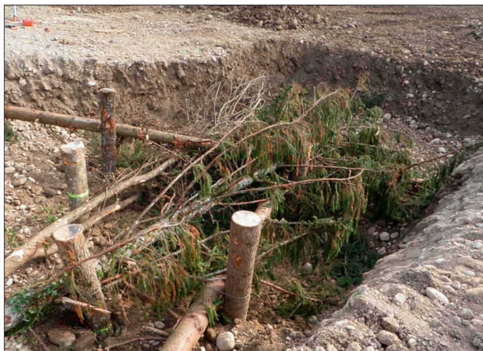
Abb. 3: Einbau einer Baumbühne mit Nadel- und Laubbäumen (Foto: Tiefbauamt Kanton Zug).
