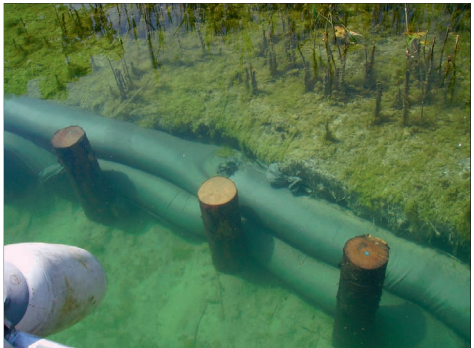
Abb. 5: Kliffkantenschutz Buonas mit Geotextilwalzen; 2009.
