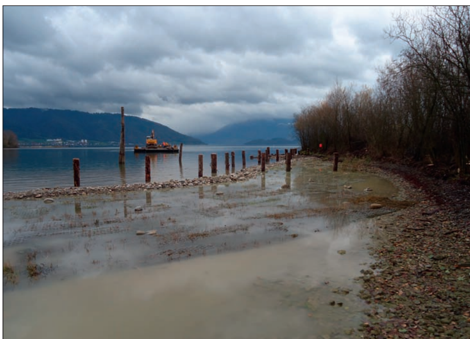
Abb. 8: Flachwasserbereich Sporn Choller-Rus unmittelbar nach Einbau der Vegetationsmatten. Fig. 8: Secteur d'eau plate, éperon de Choller-Rus directement après l'installation des nattes de végétation.
