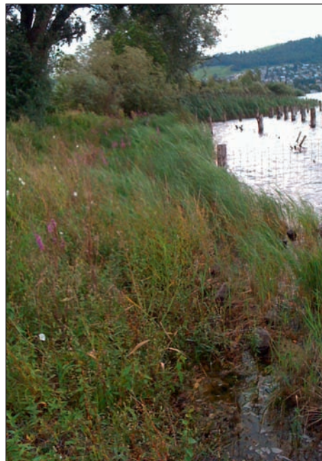
Abb. 6: Matten und Faschinen im Sommer (ca. 5 Monate nach Einbau).
