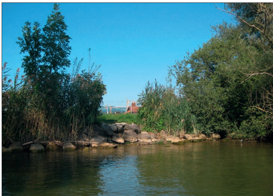
Abb. 1: Ausgangslage Flachwasserschüttung Choller (Blockwurf).
