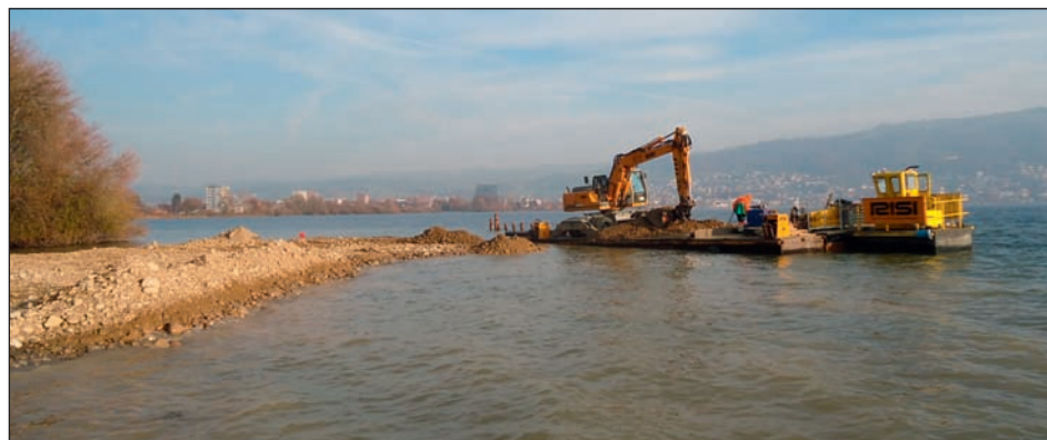
Abb. 3: Schüttung Kiesinsel mit Hilfe eines Pontons.
