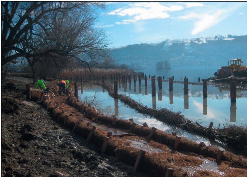
Abb. 5: Initialbegrünung der Uferlinie mit vorkultivierten Vegetationsmatten und -walzen. Vorgelagerte Totholzfachine als Sedimentfang. Pfähle für Schilfschutzzäunung inkl. Querschläge.
