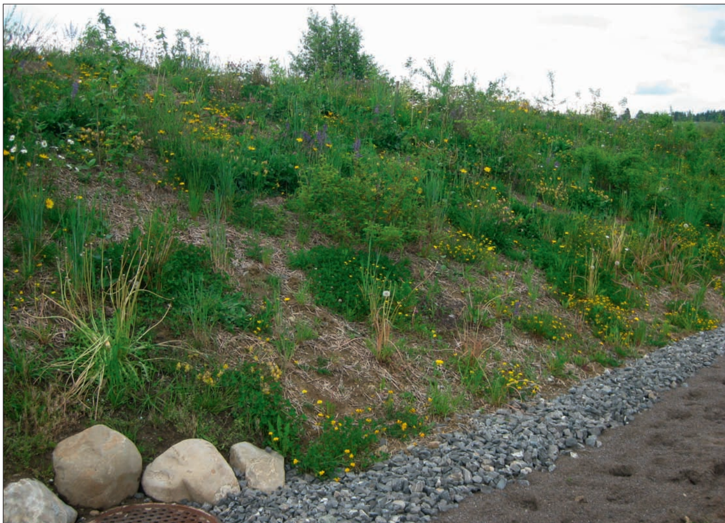
Abb. 5: Vegetationsstand des Lärmschutzdamms rund zwei Jahre nach Einbringen der Hydrosaat (Bild: Tiefbauamt des Kantons Zug).
