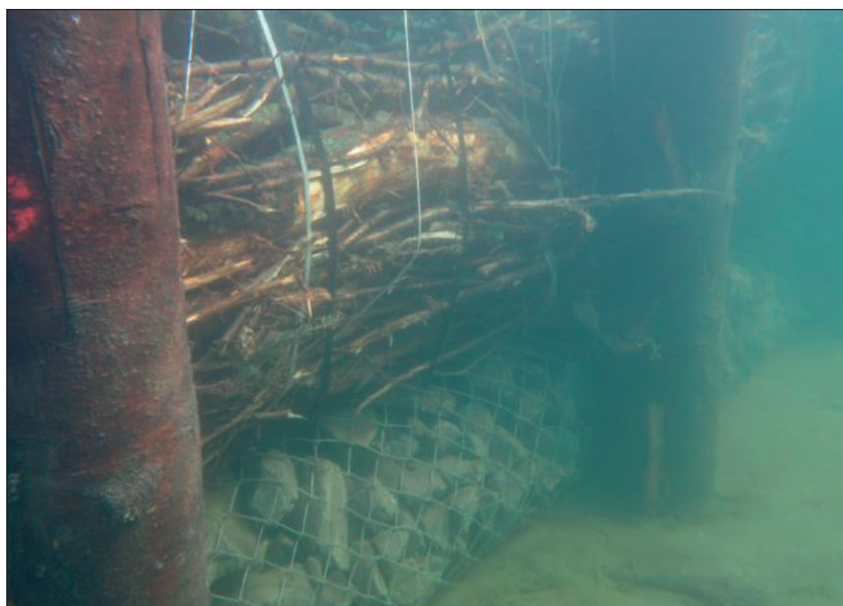
Abb. 4: Unterwasseraufnahme Fuss-Sicherung und Lahnung; Habitatstrukturen für Jungfische.
